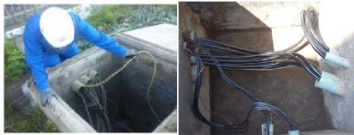
**Fotografía No. 58 Mantenimiento a Registros de cableado del transformador**
