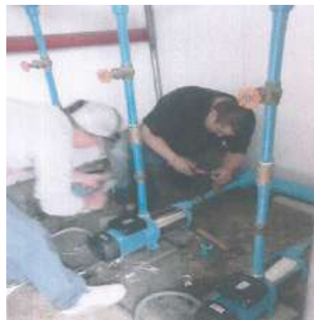
Imagen 30 Mantenimiento de sistema
