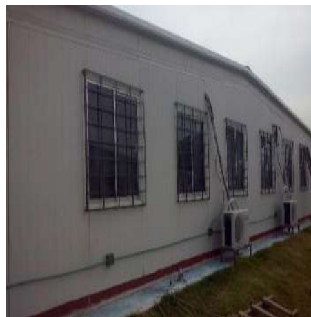
Imagen 41 Instalación de Protecciones
