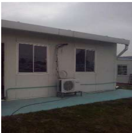
Imagen 40 Instalación de Aires Acondicionados
