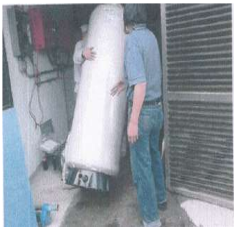
Imagen 29 Colocación de Bombas hidráulico
