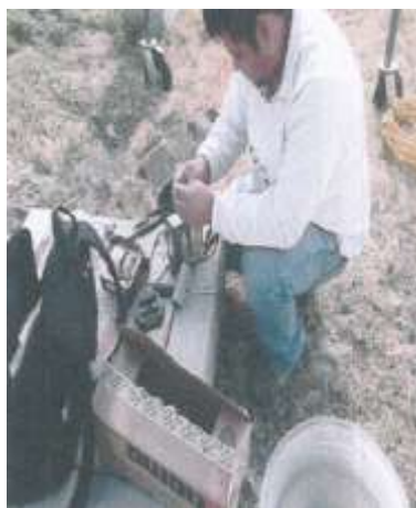
Imagen 32 Mantenimiento a red eléctrica exterior
