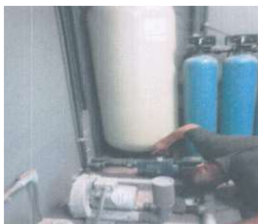
Imagen 39 Cambio de Válvulas Check
