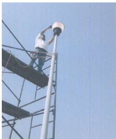
Imagen 31 Cambio de Lámparas Exteriores
