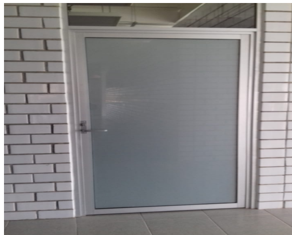
Colocación puertas de Laboratorio de Mecánica y Auditorio
