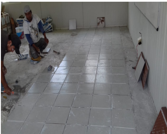
Colocación piso a aulas prefabricadas módulos B, C, D
