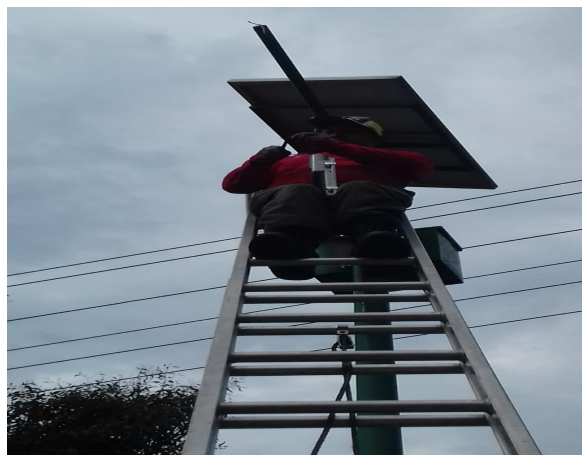
Mantenimiento a Luminarias de Tecnológico
