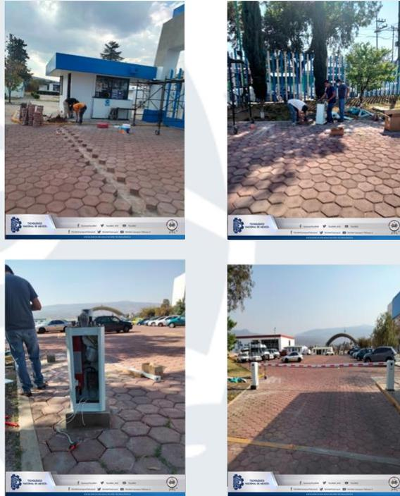
*Ilustración 63 Instalación de plumas en estacionamiento de apertura con tarjeta electrónica*
