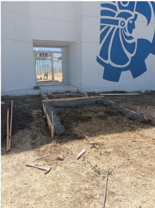
Rampa de emergencia del Auditorio.
